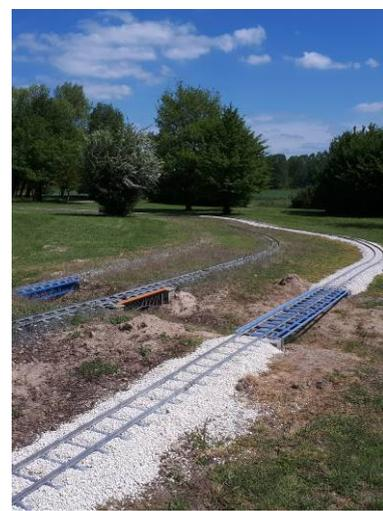
De nouveaux ponts, un nouvel évitement, le rétablissement du raccourci en sortie de dépôt, la modification d'un évitement pour plus de sécurité, l'amorce du raccourci vers le nouveau terrain.
