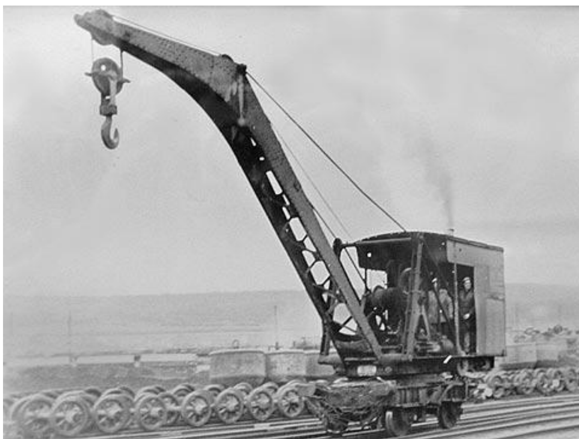
Petite grue à vapeur de manutention sur parc à essieux (photo X).
