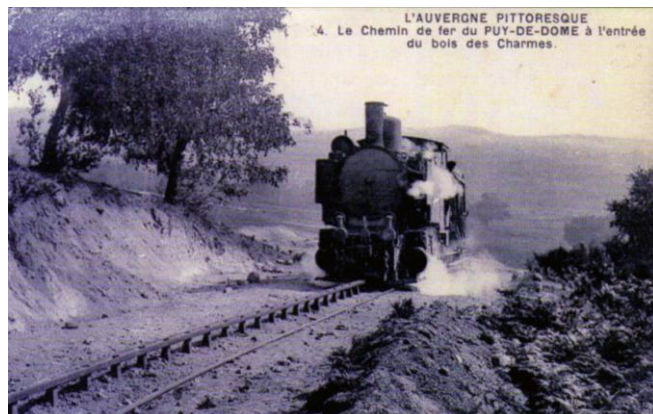
Voie équipée du rail central sur les flancs du Puy-de-Dôme.
