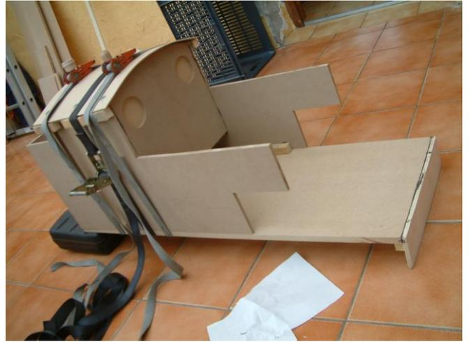
Mise en place du toit ; il sera maintenu ainsi pendant 24 heures. Sa fixation sera ensuite renforcée par 6 vis.
