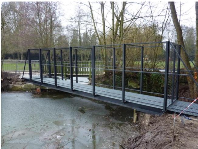
Dans « La Boîte à Fumée » n°14 vous aviez découvert le pont métallique destiné à être implanté sur le réseau de l'A.V.O. (Amis de la Vapeur de l'Oise). Achevé, sorti d'usine, celui-ci fut transporté sur son site définitif puis mis en place sur les deux culées prévues à cet effet. Le voici maintenant muni de ses protections hautes et fin prêt à prendre du service.
