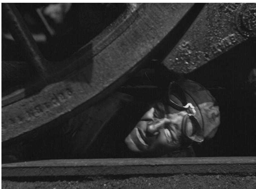
*Mais imaginez maintenant l'ouvrier devant resserrer des boulons dans les « BP » d'une locomotive en service (donc chaude) : il doit se glisser entre les longerons toujours très gras, à la lueur d'une lampe à carbure, trainant les clés plates ou à tubes.....*
